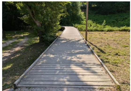
Joonis 6. Kruusakattega rada, mis läheb sujuvalt (ilma lävepakuta) üle puitlaudteeks
