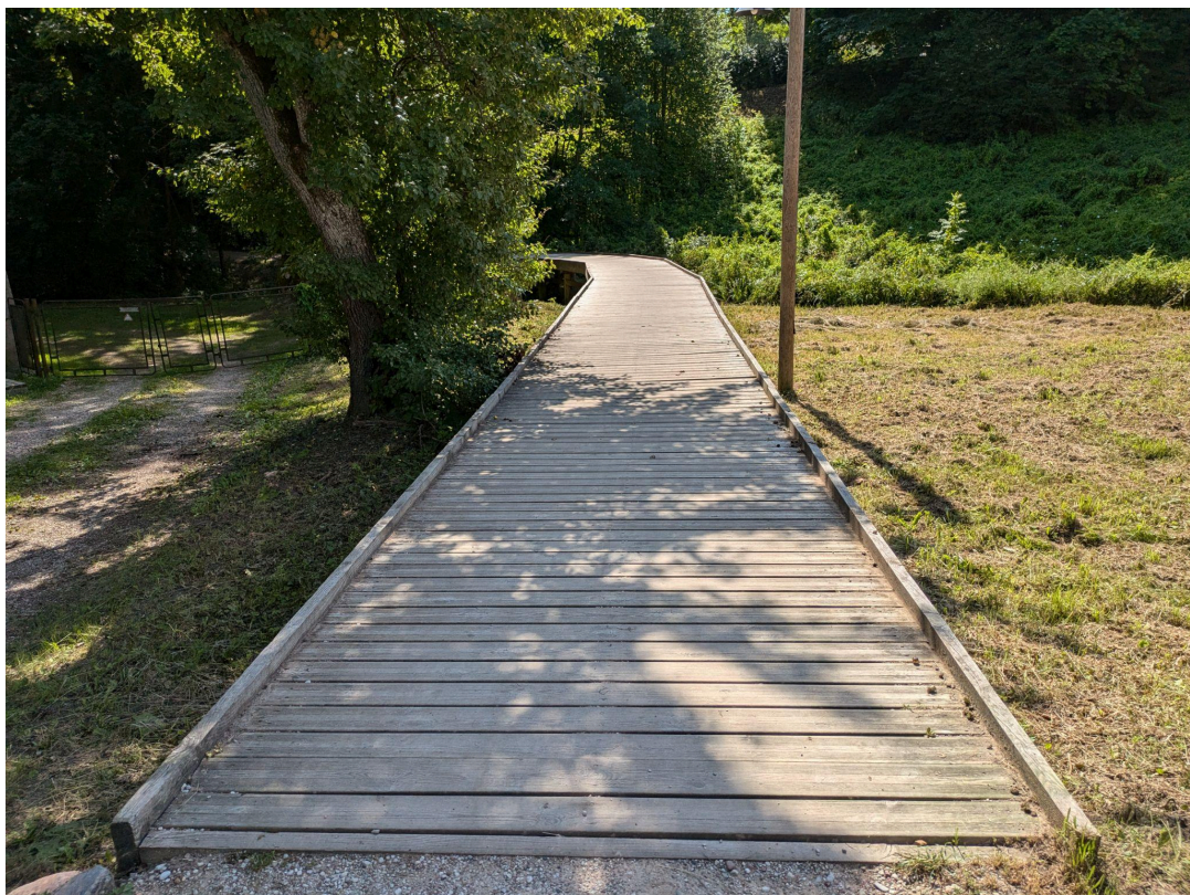
6. attēls. Taka ar grants segumu vienlaidus (bez sliekšņa) pāriet koka laipā
